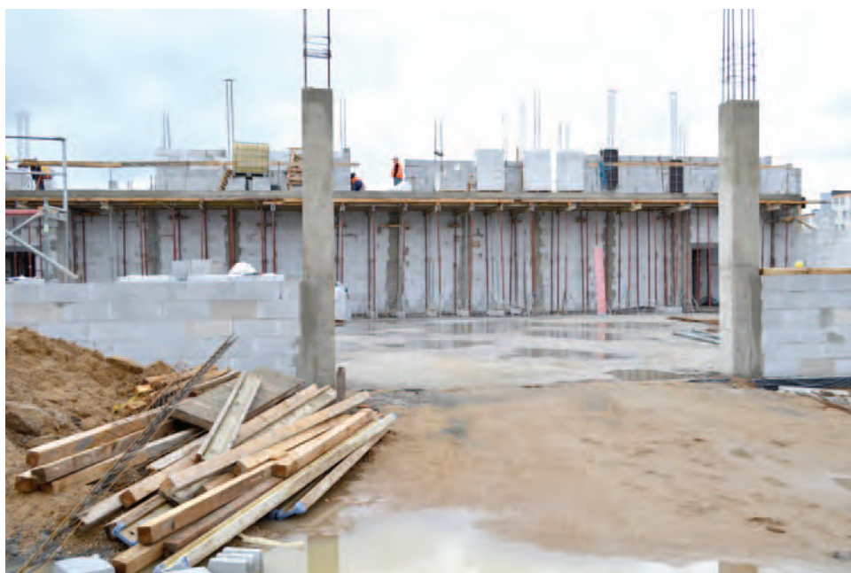
Budowa olawskiego Powiatowego Centrum Edukacyjno-Rehabilitacyjnego z Zespołem Szkół Specjalnych przebiega bez większych zakłóceń i jest już zrealizowana co najmniej w piętnastu procentach
