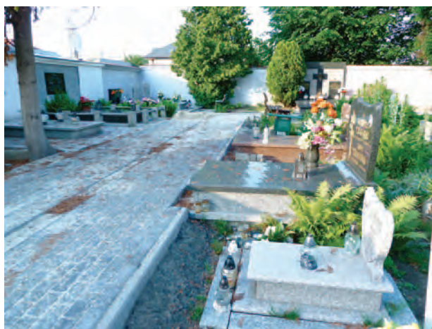
W niektórych miejscach trzeba omijać nieprawidłowo usytuowane pomniki nagrobne
