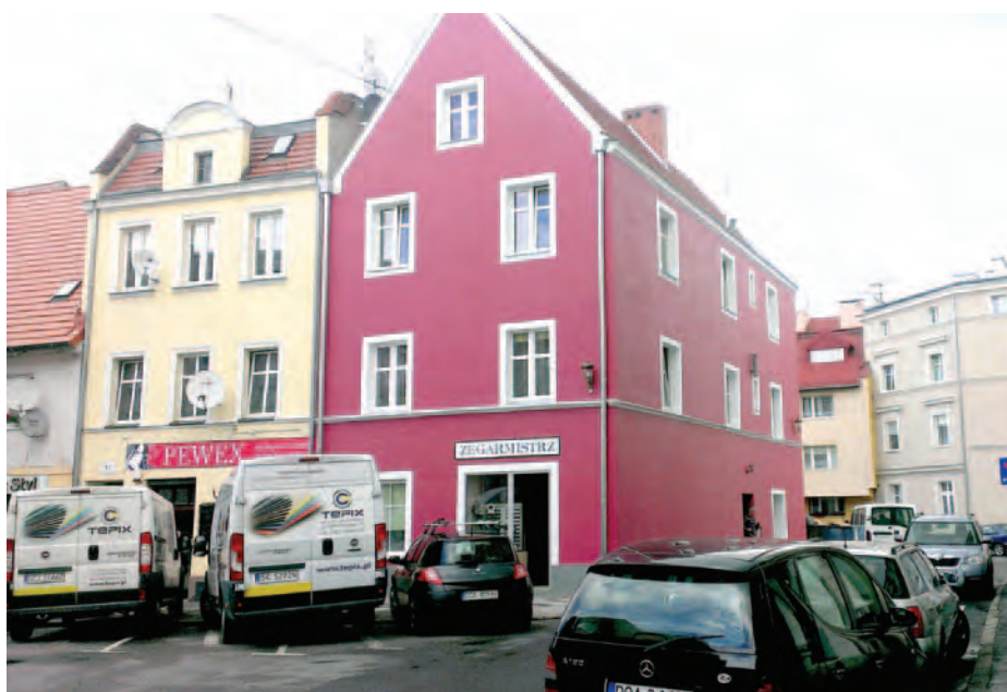
Kolejne kamieniczki w centrum Olawy odzyskują blask. Tym razem na placu Starozamkowym
