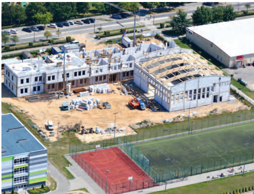
Dobiegają końca prace przy budowie pierwszego piętra obiektu głównego, a nad halą sportową powstaje dach
