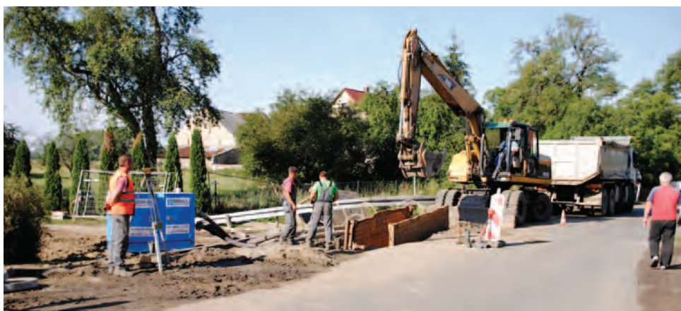
Kanalizację w Sobocisku buduje firma „Energy Investor” z Brzegu. Jest jedną z trzech, które budują kanalizację w pięciu miejscowościach gminy Oława
