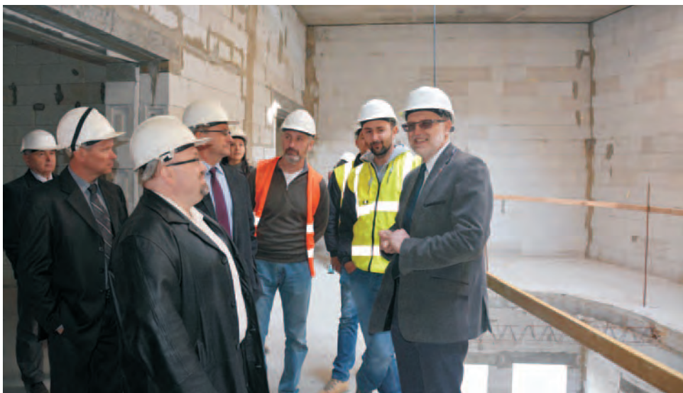
Przedstawiciele wykonawcy i samorządowcy na budowie
