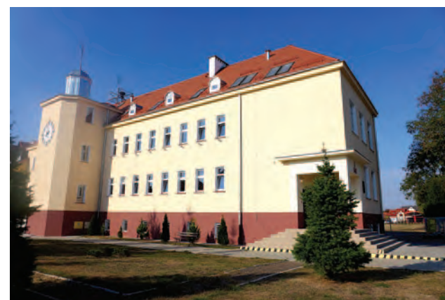
Budynek SP nr 4 ma nową elewację
