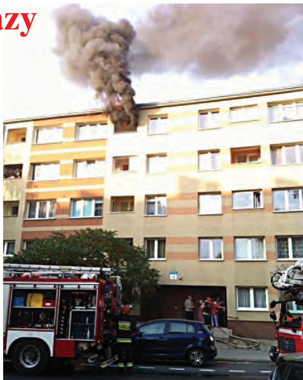
Prace przy instalacji gazowej były powodem pożaru w mieszkaniu na czwartym piętrze przy ul.3 Maja
