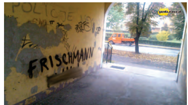
Tak wygląda przejście przy ulicy Własta
