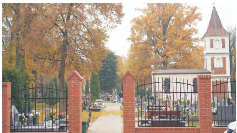
Budowa ogrodzenia dobiega końca
