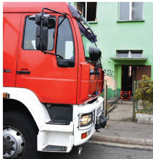
W korytarzu tego budynku doszło do pożaru
