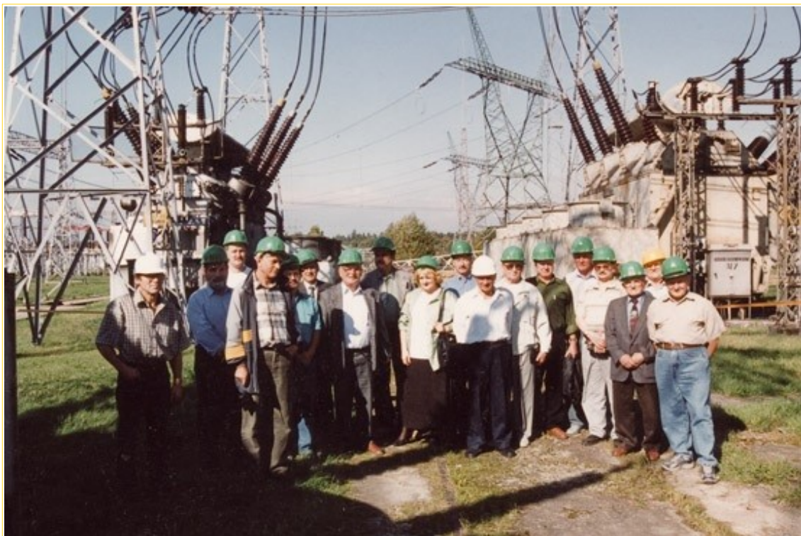
Stacja rozdzielczo-transformatorowa WN 400/220/110 kV Mikułowa, 2001 r., fot 2.
