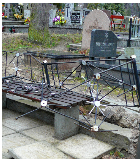
Efekt osunięcia się pnia na ogrodzenie grobu.
