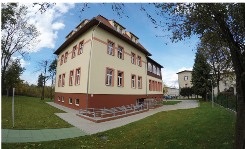
Ponemiecki budynek został rozbudowany i docieplony.
