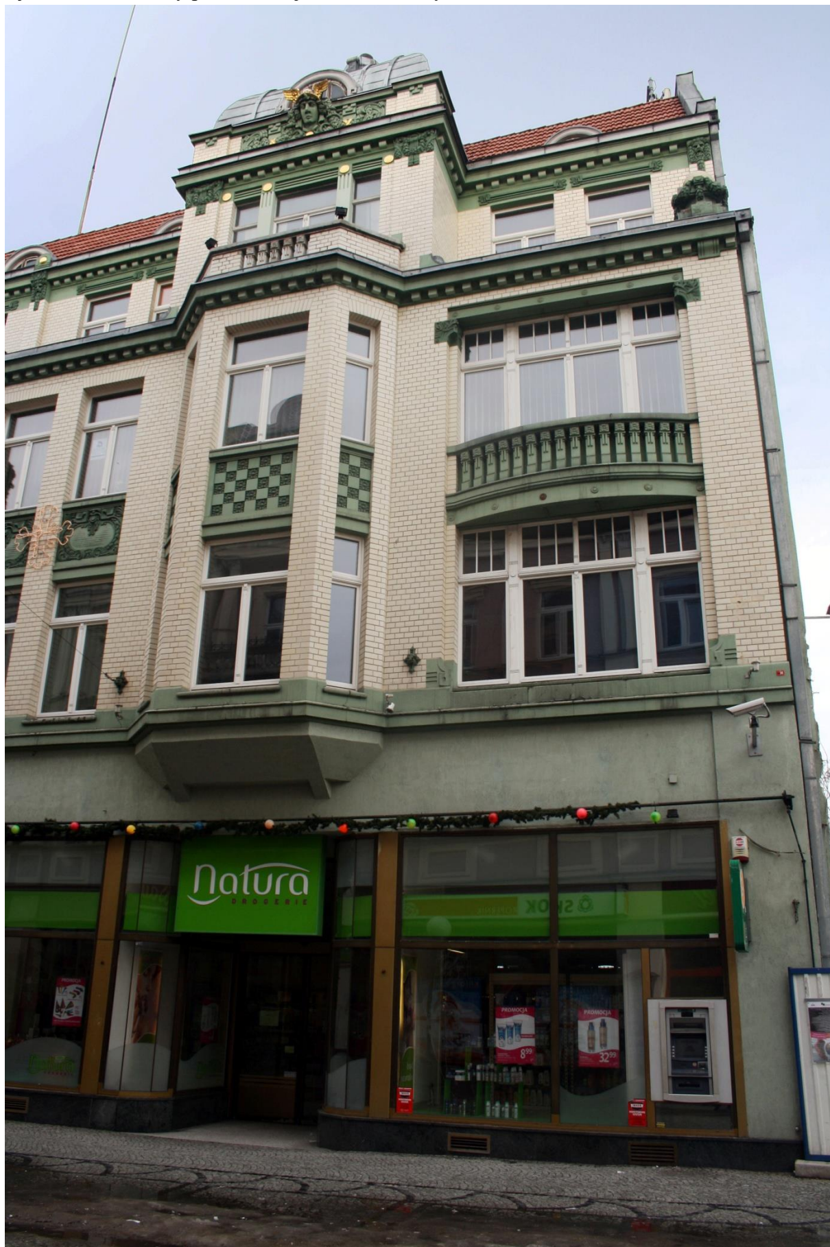
Ryc. 23 Okna fasady południowej oraz ornamenty architektoniczne
