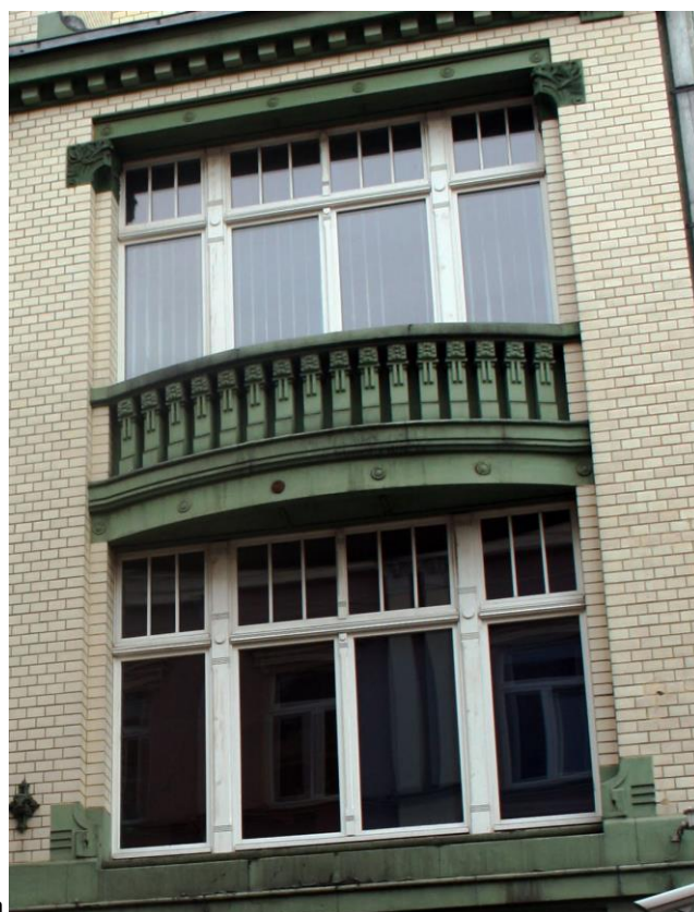
Ryc. 22 Okna i balustrada
