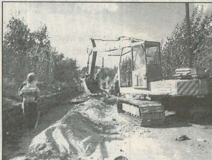
Na placu budowy widać już pracowników firmy INTEGRA
