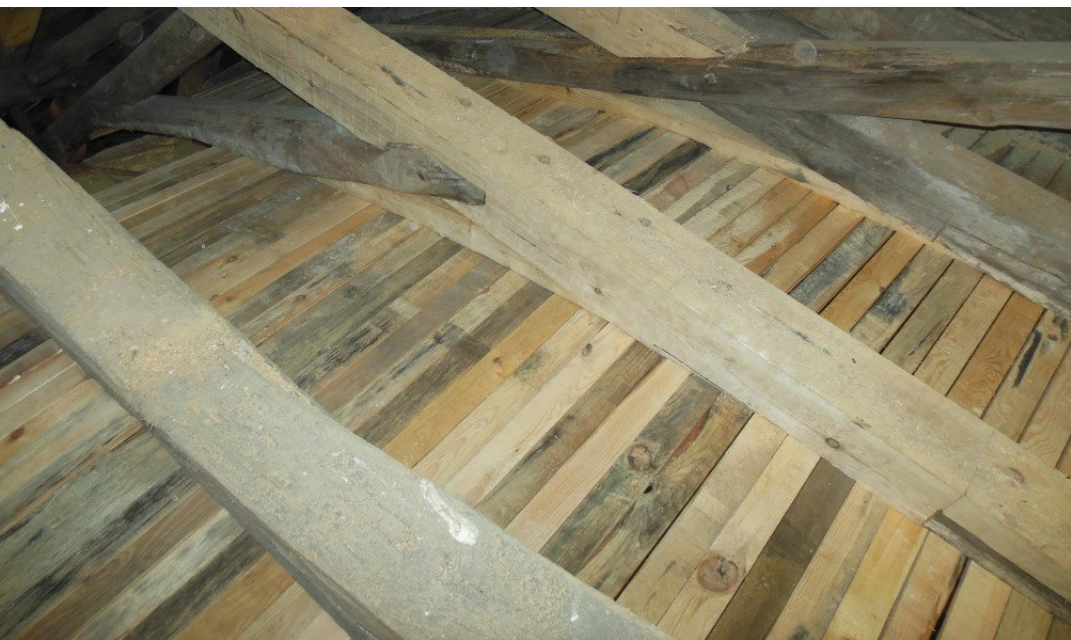
Zdjęcie znad odtworzonej konstrukcji szkieletowej kopuły fot. arch. fundacji "Twoje Dziedzictwo"
