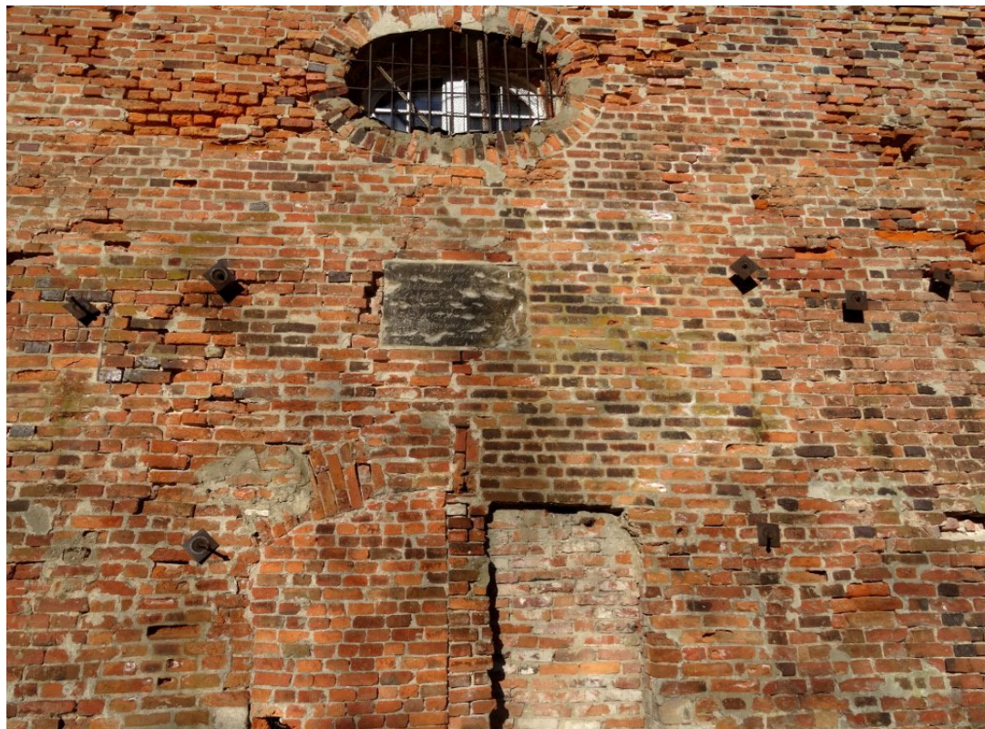
Kurtyna fosy z tablicą z 1814 r. Poniżej widoczne zamurowane wejście do poterny fot. Paweł Łachowski
