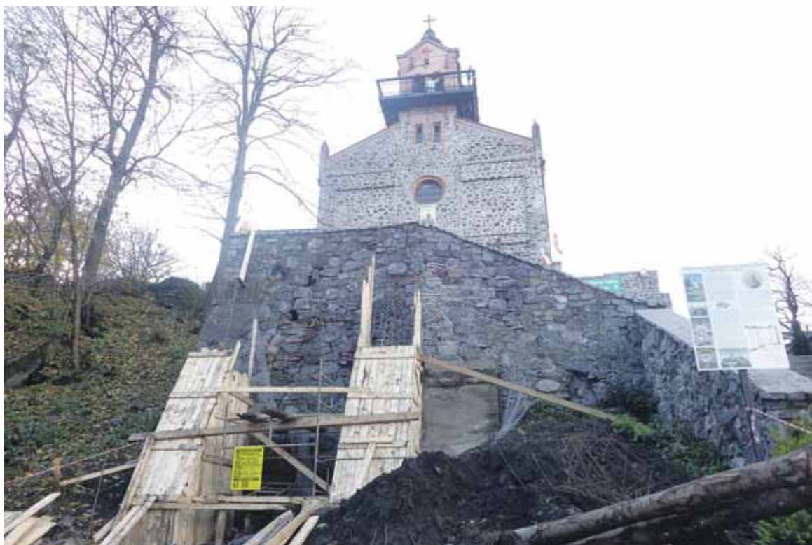
Remont groty, która służyła niegdyś jako schronisko
