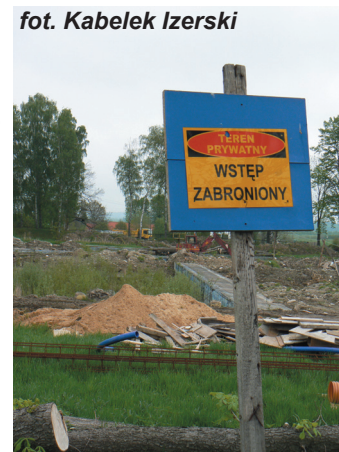
Panorama placu budowy.
