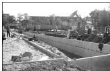
Ä Budowa boiska przy SP nr 5
