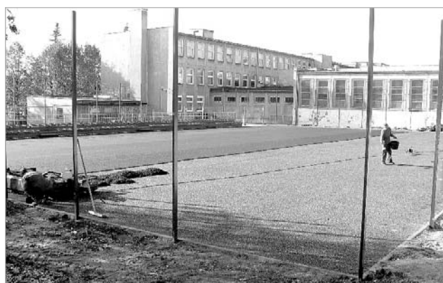
■ Budowa boiska przy Szkole nr 5.
