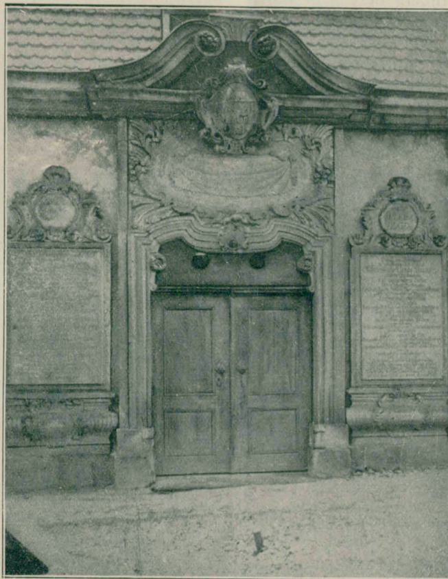
FASSADE DER MENTZEL-GRUFTEKAPELLE.
