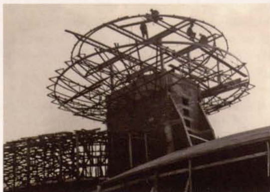
Budowa obserwatorium meteorologicznego na Śnieżce
