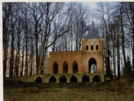
Opactwo w odbudowie
