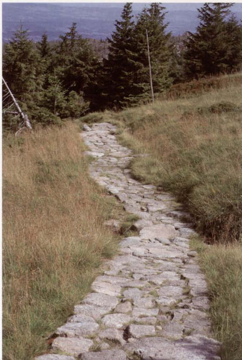
Szlak po modernizacji, dobrze wkomponowany w otoczenie
