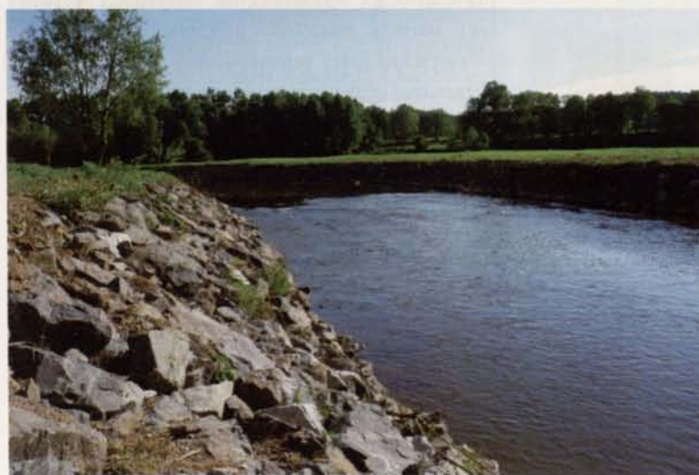
Brzegi Bobru po regulacji przeprowadzonej poza chronionymi terenami parków przypałacowych w Łomnicy
