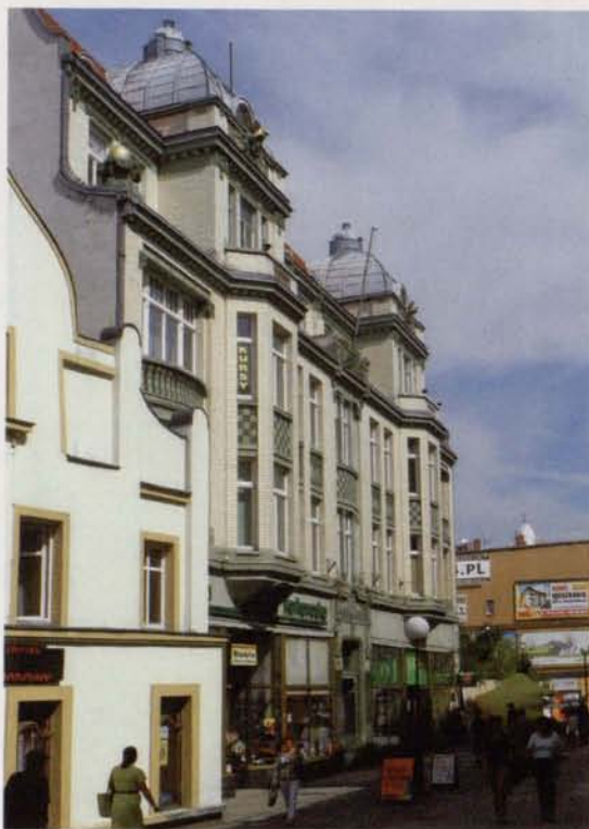
Dawny dom handlowy spółki „Staeckel & Co”, obecnie siedziba Głównego Urzędu Statystycznego
