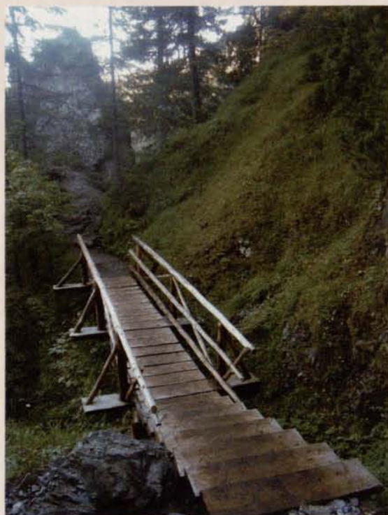
Wyremontowany odcinek Ścieżki nad Reglami w Tatrach
