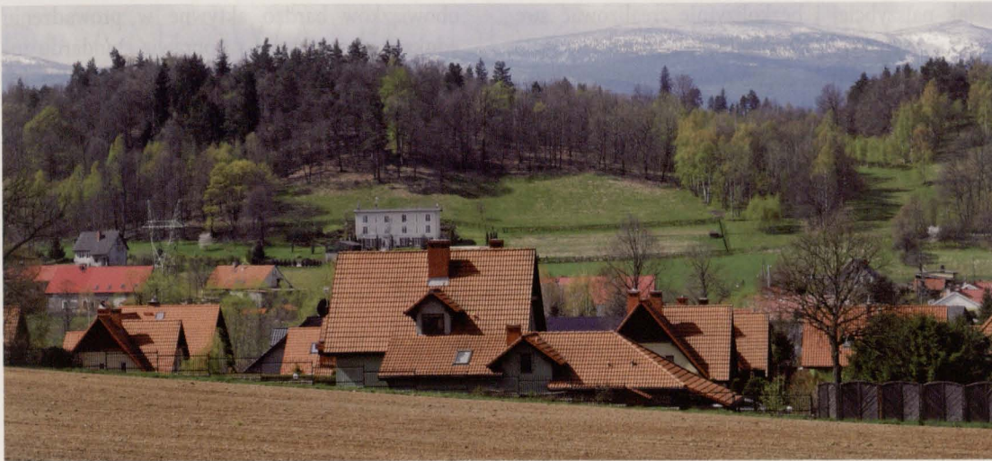
Osiedle domków jednorodzinnych o zbliżonej architekturze na Czarnem w Jeleniej Górze
