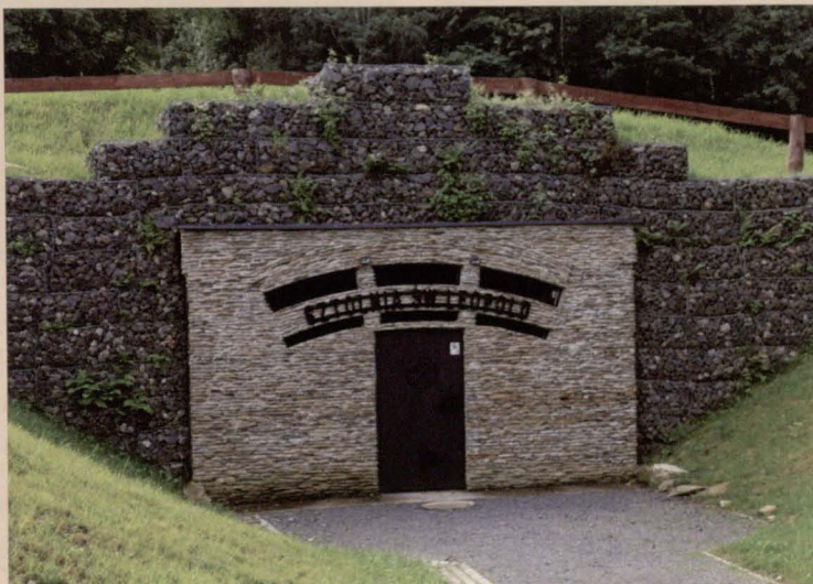
Wejście do sztolni dawnej kopalni w Krobicy
