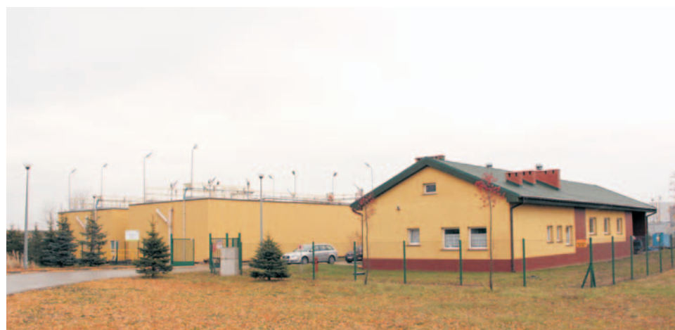
Dofinansowanie obejmuje oprócz refundacji kosztów budowy kanalizacji sanitarnej w Stanowicach i Marcinkowicach także refundację kosztów budowy oczyszczalni ścieków w Stanowicach
