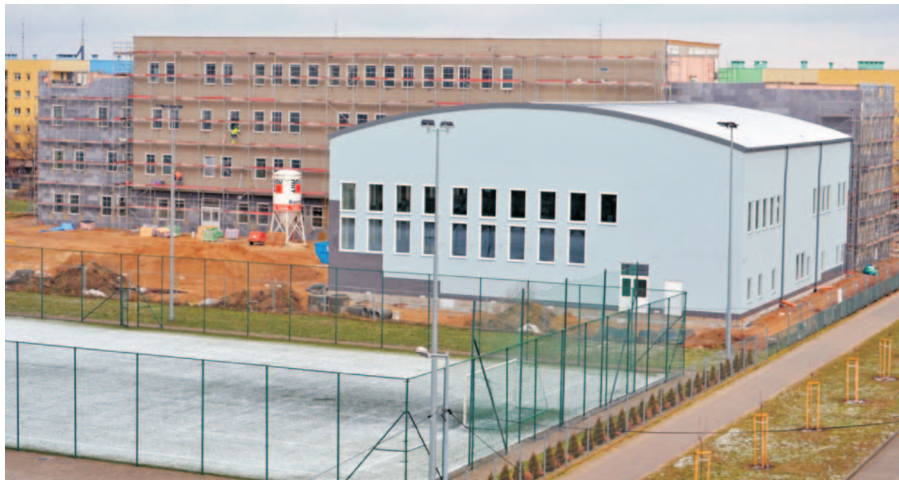
Budowa Powiatowego Centrum Edukacyjno-Rewalidacyjnego z Zespołem Szkół Specjalnych w Oławie jest już w stanie surowym zamkniętym. Rozpoczęto prace wykończeniowe
