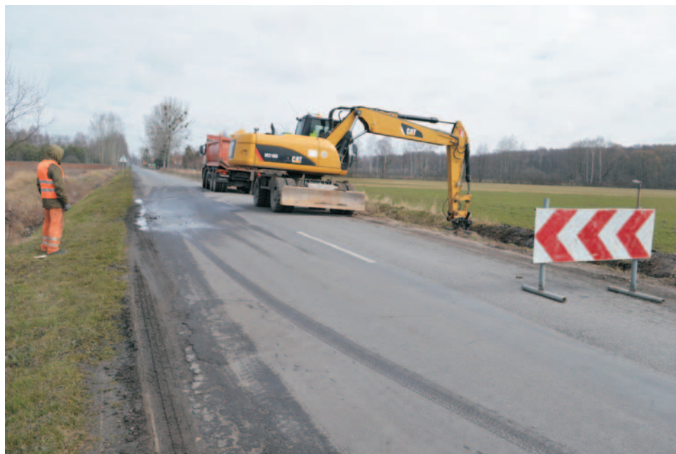
Wyremontowanie fragmentów dwóch dróg powiatowych na trasie z Jelcza-Laskowic do Oleśnicy zdecydowanie poprawi komunikację między autostradą A4 a drogą ekspresową S8
