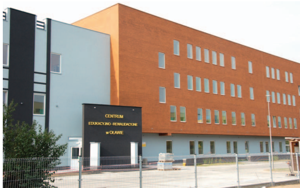
Budowa centrum zbliża się do końca
