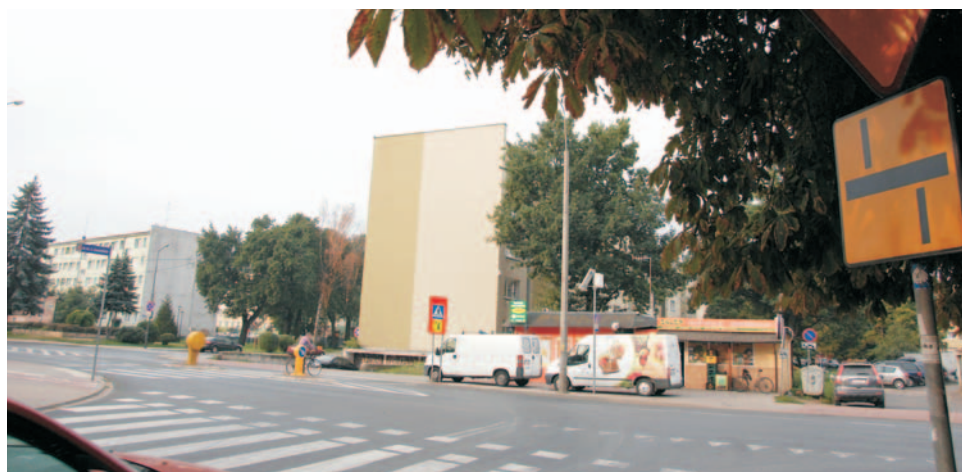
Wyjazd z ul. ks. Janowskiego. Brak znaku, że wjeżdża się na ścieżkę rowerową
