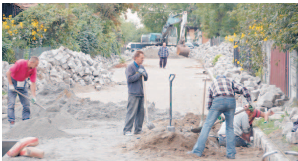
Od paru tygodni tędy nie da się przejść. Wykonawca zapewnia, że zdąży z robotami do końca października
