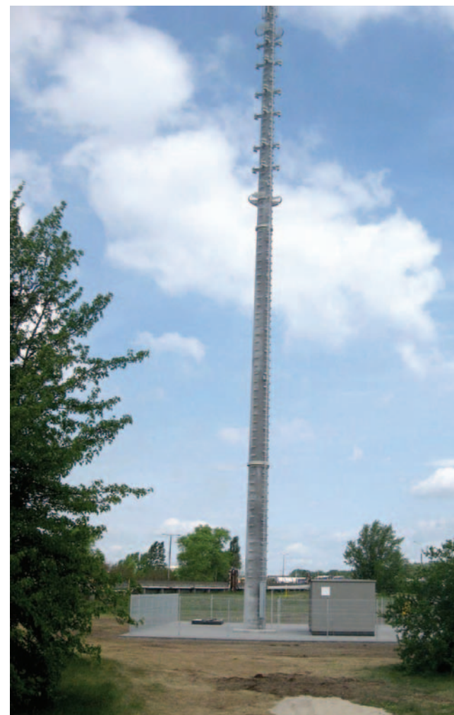
Tego typu wieża z systemem anten stanie na dzikim w gminie Domaniów
