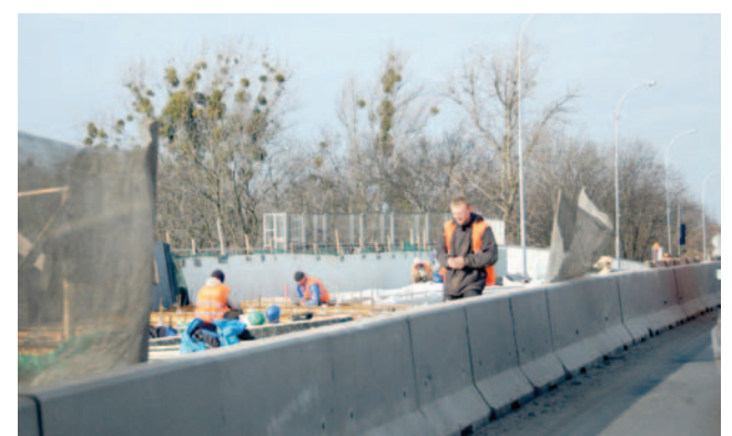
Prace na wiadukcie przy ulicy Opolskiej mają zakończyć się w kwietniu
