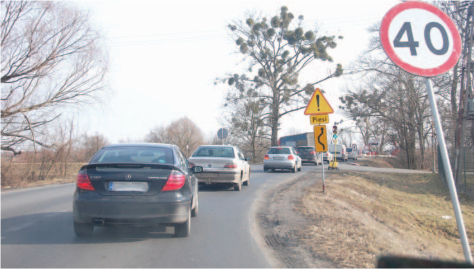
W Jaczkowicach trwa remont mostu, zakończy się pod koniec maja. Wprowadzono sygnalizację świetlną, obowiązuje ruch wahadłowy...
