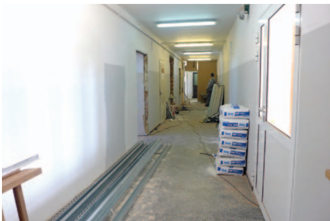
Zaplecze sali gimnastycznej SP nr 4 po remoncie będzie jak nowe
