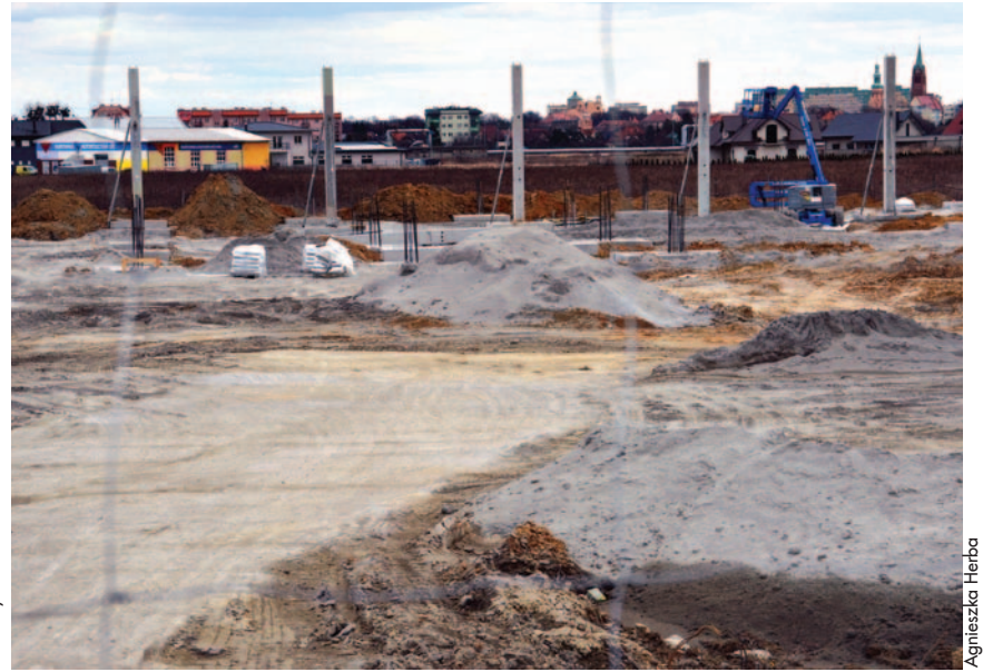
W tym miejscu już dawno miała powstać galeria handlowa, wcześniej inwestor wycofał się. Czy tym razem wszystko pójdzie zgodnie z planem? Na razie prace idą pełną parą
