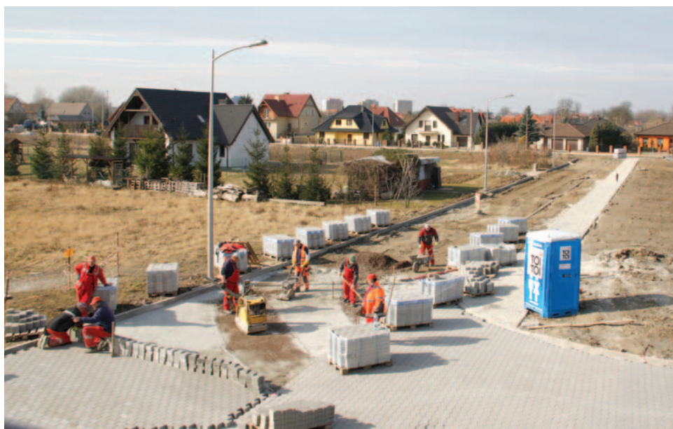
Drogi i chodniki na olawskim Zaodrze są wykonywane z kostki brukowej
