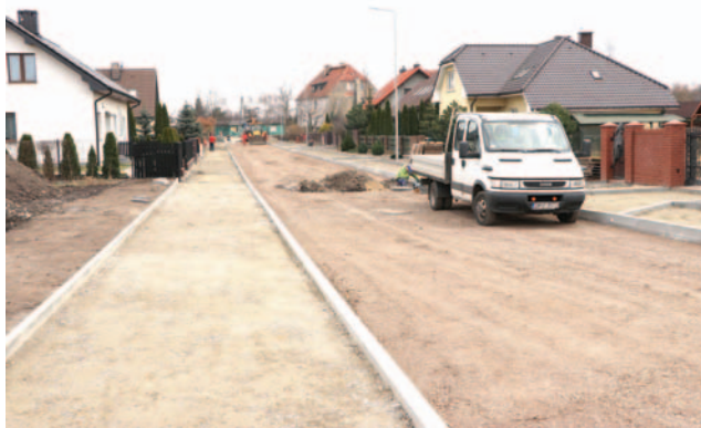
Budowa ulicy Sowińskiego szybkimi krokami zmierza do finału
