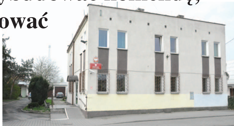
Budynek komisariatu jest w złym stanie technicznym
