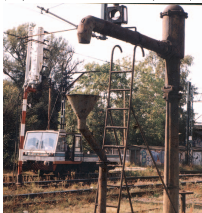
Nieistniejący już żuraw wodny (tu na fot. z 2005 roku) byłby z pewnością ciekawym zabytkiem oławskiej kolei
