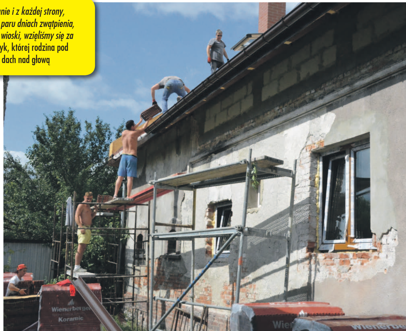
Ekipa remontowa uwija się, by jak najszybciej położyć spalony dach
