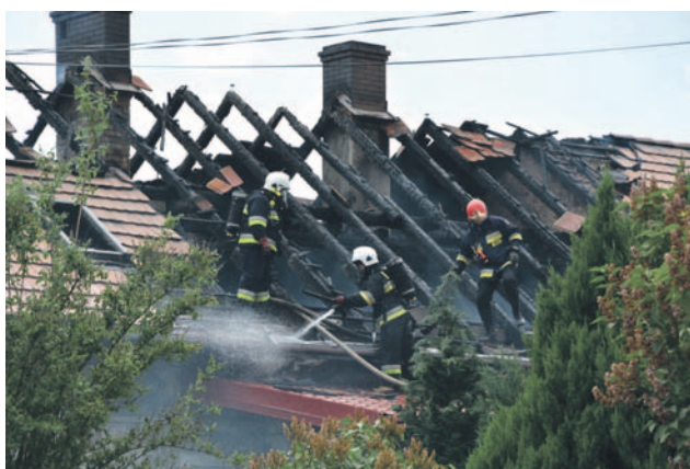
W pożarze 29 maja dach domu spłonął doszczętnie
