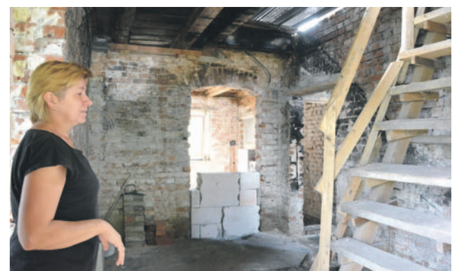
Wewnątrz budynku jest jeszcze dużo do zrobienia, ale pani Małgorzata wierzy, że przed zimą wróci do domu
