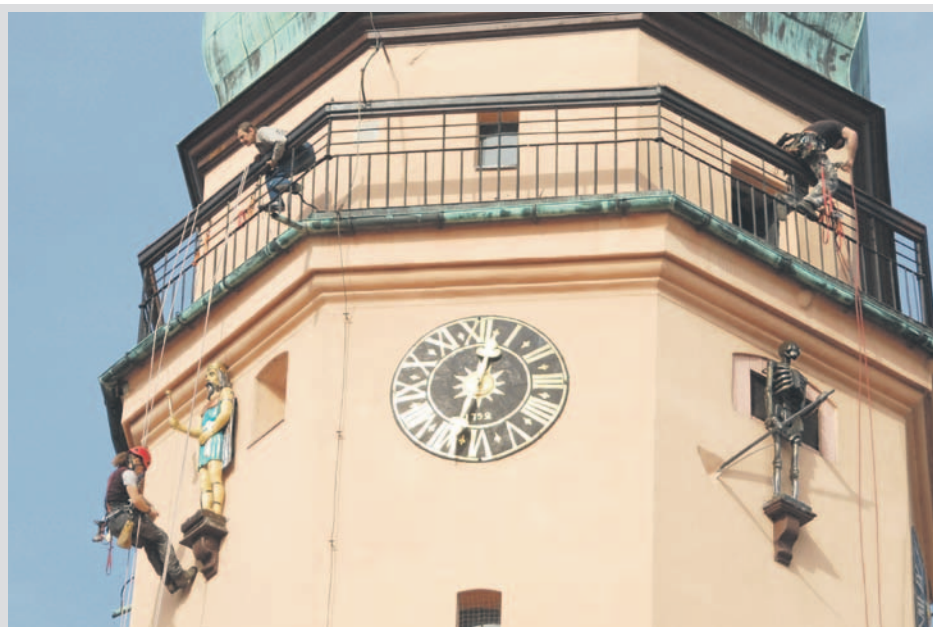
Odmłodzone figury już na swoim miejscu
