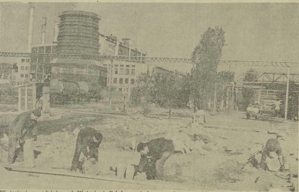
W jesieni na odcinku od Wytwórni Celulozowej do nowych warsztatów SOWI prowadzone były prace drogowe. Na zdjęciu fragment tych prac.
