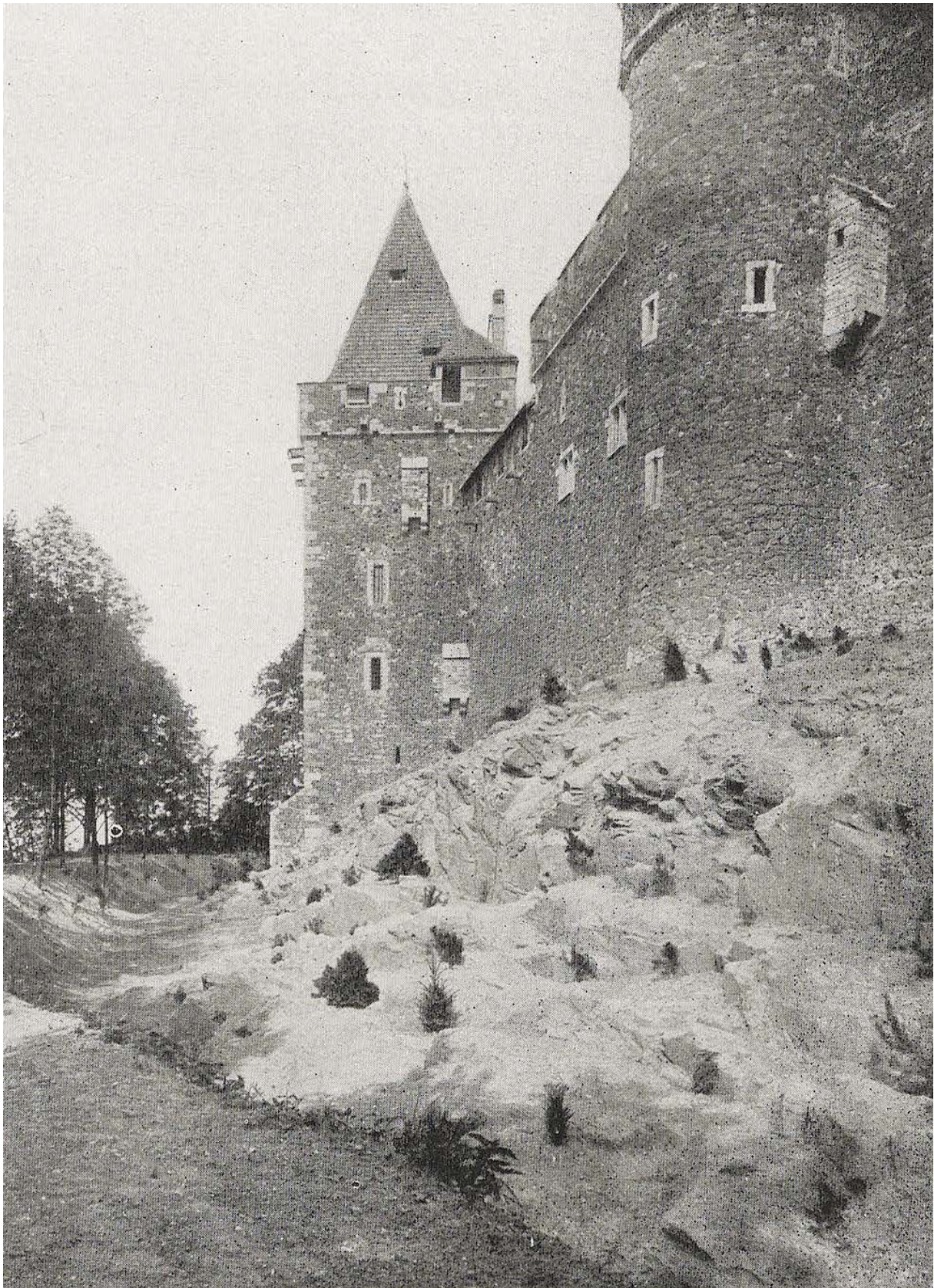
Abb. 4. Gröditzberg, Nordmauer des Pallas, Blick gegen Osten.
