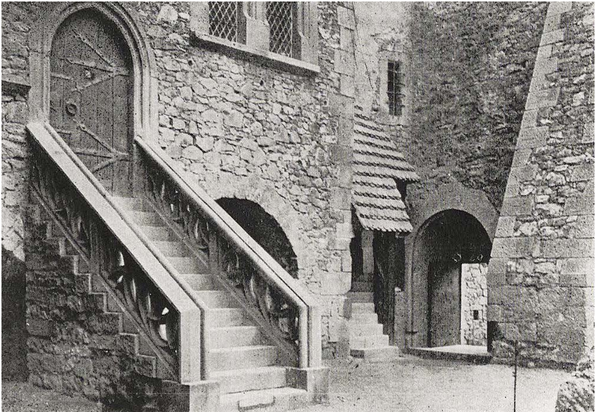
Abb. 7. Gröditzberg, Verbindungsbau mit Treppe
