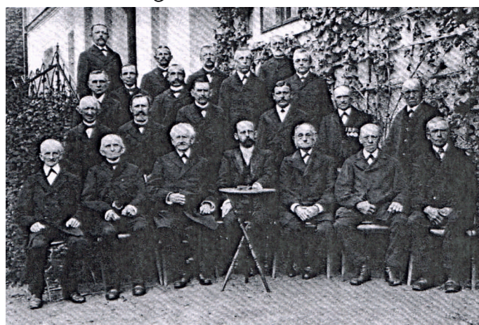
Rada Gminy i Rada Parafii Gebhardsdorf, zdjęcie wykonane na schodach ówczesnego budynku probostwa (Pfarrhaus), obecnie dom państwa Kotlińskich.
