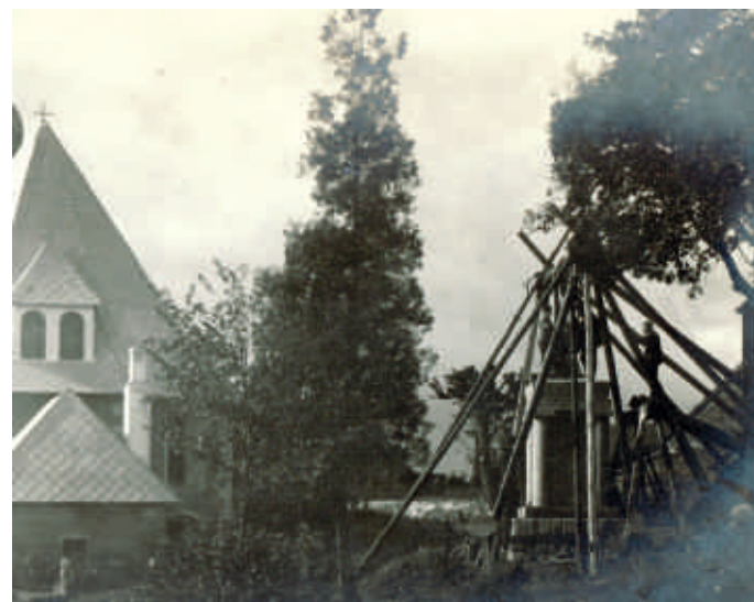
Budowa drugiego pomnika poległych 1914-18. - fotografia ze zbiorów P.Czembrowskiego
