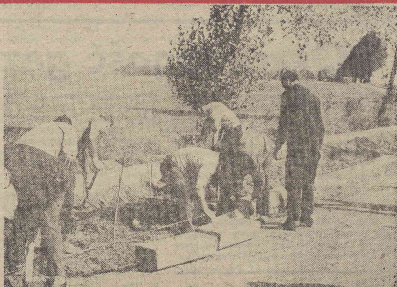
Na zdjęciu: praca przy budowie chodnika w kierunku Grzegorzewa. Fot. B. Wudarski
