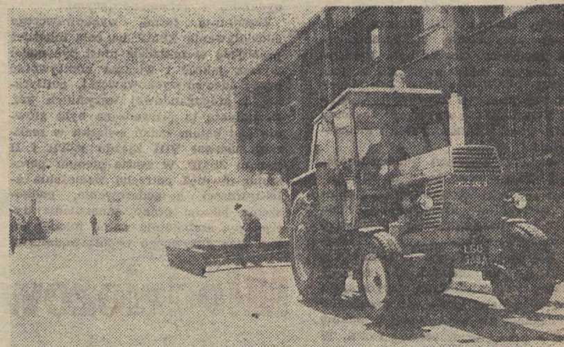
Na zdjęciu: Asfaltowanie ul. „Marszałkowskiej”. Fot. R. Wudarski
