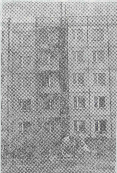
W osiedlu przy ul. Metalowców Fot. F. Kopeć
