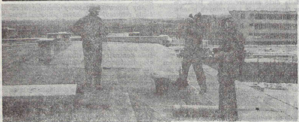
Czy nadchodząca jesień znowu przyniesie stale odgrzebywany problem ciekających dachów? Jak widać, prace zabezpieczające przed przeciekami są prowadzone. Czy jednak będą na tyle skuteczne? — fot. F. Kopeć
