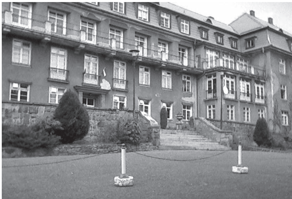
Ryc. 5. Wojewódzki Szpital Rehabilitacyjny w Janowicach Wielkich, dzisiaj
