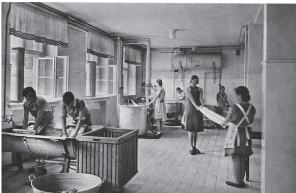
Ryc. 4. Pralnia Dziecięcego Domu Wypoczynkowego do 1945 r.
